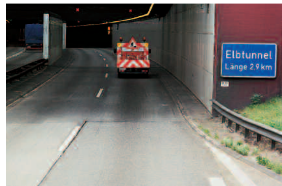
Nedkørslen til Elbtunnellen i Hamborg.
